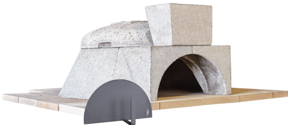
Assemblage du four avant isolation et habillage
