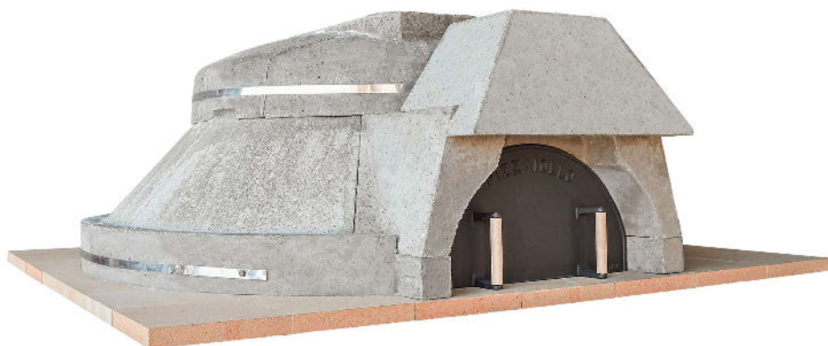
Assemblage du four avant isolation et habillage
